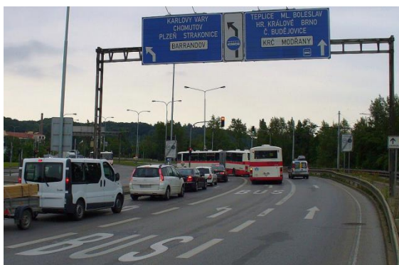
Vyhrazený řadicí pruh pro autobusy (křižovatka Modřanská x nájezd na Barrandovský most, Praha)
