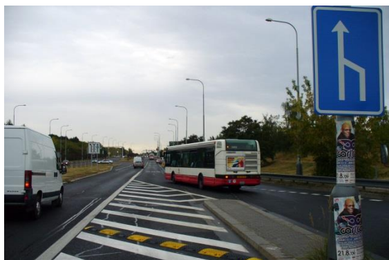
“Chráněný” výjezd autobusů veřejné dopravy z terminálu VHD [terminál “Opatov”, Praha]
