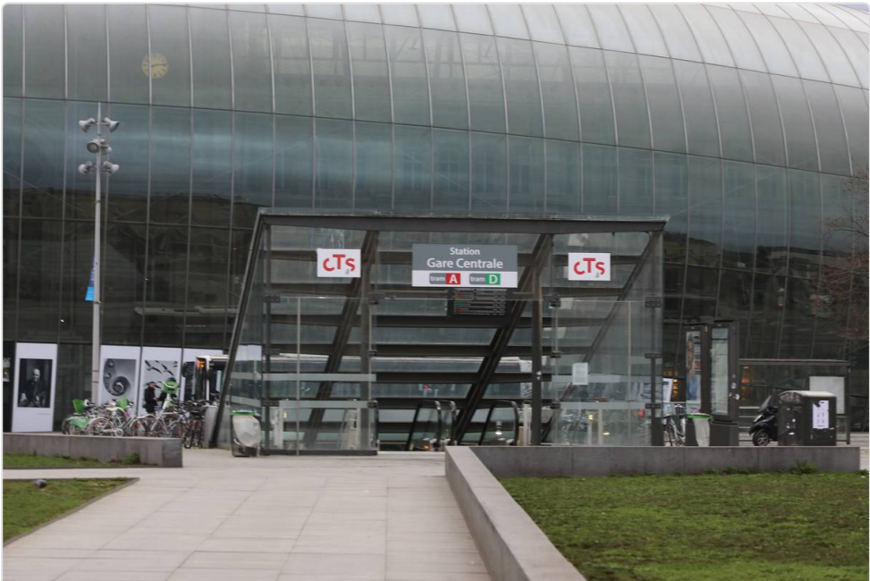
Vstup do podzemní zastávky tramvaje v uzlu s odjezdovým displejem na povrchu. Štrasburk, Francie
