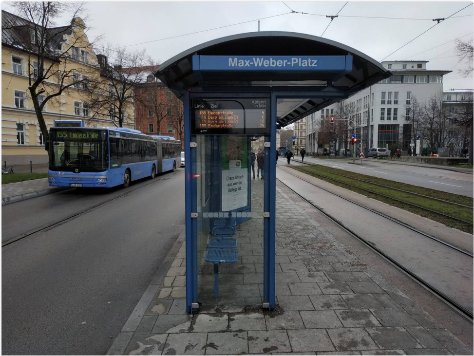
Přístřešek s odjezdovým displejem z vnitřní i vnější strany, foto Filip Drápal, Mnichov, Německo
