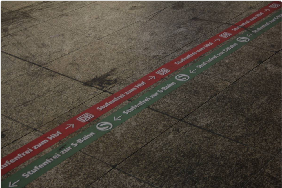
Navigační pásy k bezbariérovému přístupu. Mezinárodní pictogram by byl vhodnější. Hlavní nádraží ve Stuttgartu, Německo
