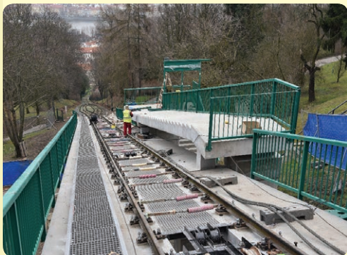
Stanice Nebozízek už je téměř připravena pro příchod prvních cestujících.
