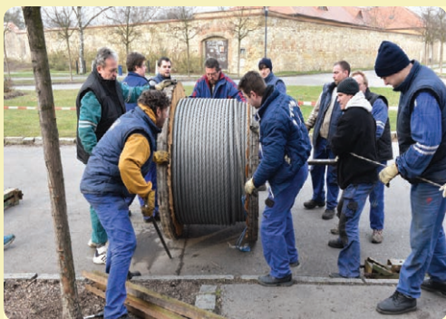
V pátek 11. března 2016 bylo natahováno nové tažné lano
