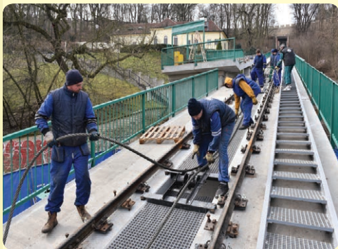
Práce s tažným lanem pod stanicí Nebozízek
