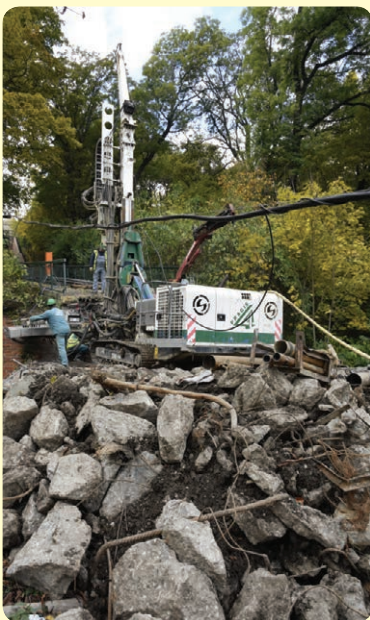
Demoliční práce v okolí stanice Nebozízek 23. října 2015
