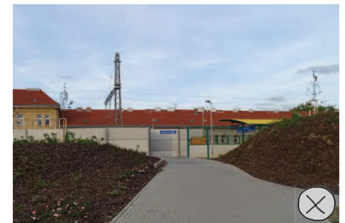
04.028 ▲ Nežřetelný přístup na nástupiště průchodem přes protihlukovou stěnu [zast. Praha-Podbaba]. #taktone #pristupnanastupiste #prothlukovastena #podbaba
