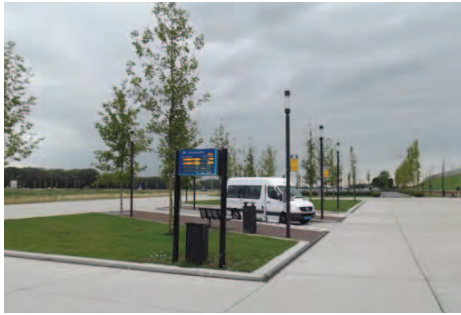
04.011 ▲ Přednádražní prostor se zastávkami návazné autobusové dopravy a parkovištěm P+R [zast. Kampen Zuid, Nizozemí]. #prednadrazni prostor #P+R #multimodalita #nizozemi #kampen
