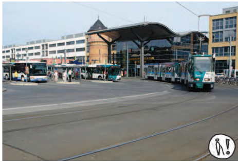
04.009 ▲ Přednádražní prostor sdílený pěšími a návaznou veřejnou dopravou [žst. Potsdam Hbf., Německo]. #prednadrazni prostor #velkyprstupnibod #tramvaj #bus #nemecko #potsdam
