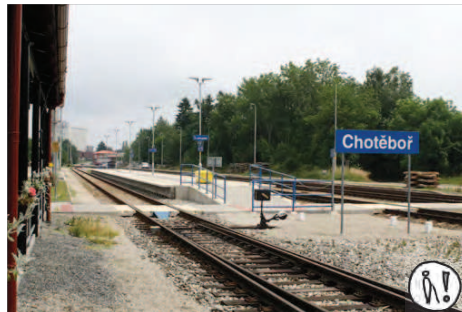
04.035 ▲ Poloostrovní nástupiště použitelné na regionálních tratích je alternativou k podchodu. V místě přecházení chybí výstražné zařízení s optickou a akustickou signalizací [zast. Chotěboř]. #nastupiste #poloostrovninastupiste #chotebor
