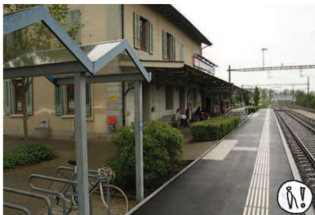
04.021 ▲ Citlivě rekonstruovaná výpravní budova s vnějším nástupištěm. Vyčkávací prostor pro cestující je realizován v rámci přístřeší výpravní budovy. V těsné blízkosti je i kryté parkoviště B+R. Celá kompozice je vhodně doplněna prvky zeleně [žst. Münsterlingen-Scherzingen, Švýcarsko]. #esko #výpravníbudova #nastupiste #B+R #svycarsko
