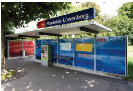
04.022 ▲ Kvalitní zastávkový přístřešek na méně frekventované zastávce [zast. Muntelier – Löwenberg, Švýcarsko]. #esko #přístresek #svycarsko
